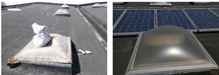
更换后的采光瓦
