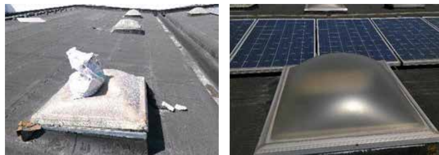
更换后的采光瓦
