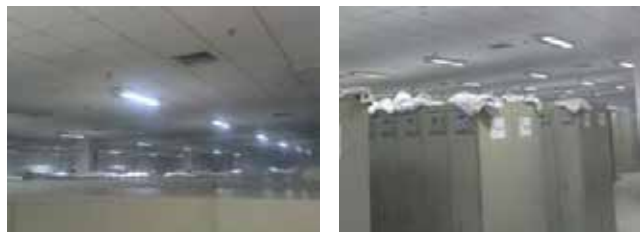
节能改造后的更衣室照明设施
