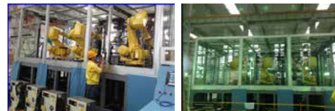
利用清洗机器人代替人工气吹工位
