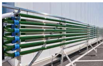
利用车辆测试用测力计排放的二氧化碳
